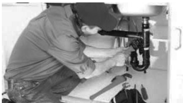
Un idraulico al lavoro
