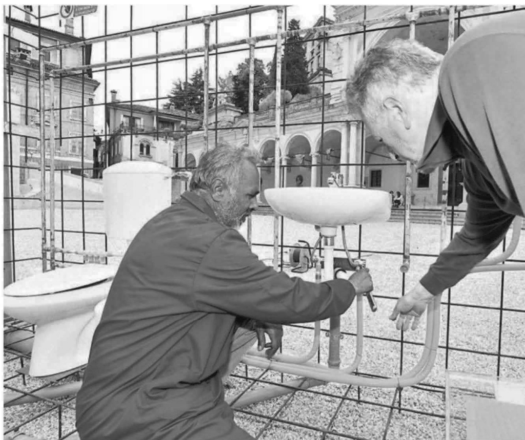
Un corso di formazione per insegnare il lavoro di idraulico
